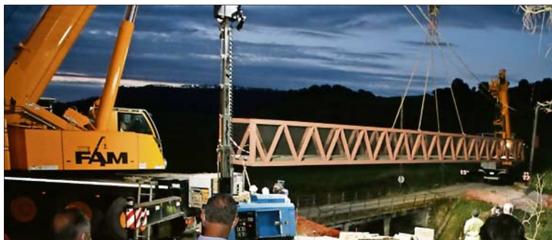
Una grúa posa la pasarela peatonal que dará servicio temporal a los vecinos. / NACHO ROMERO
