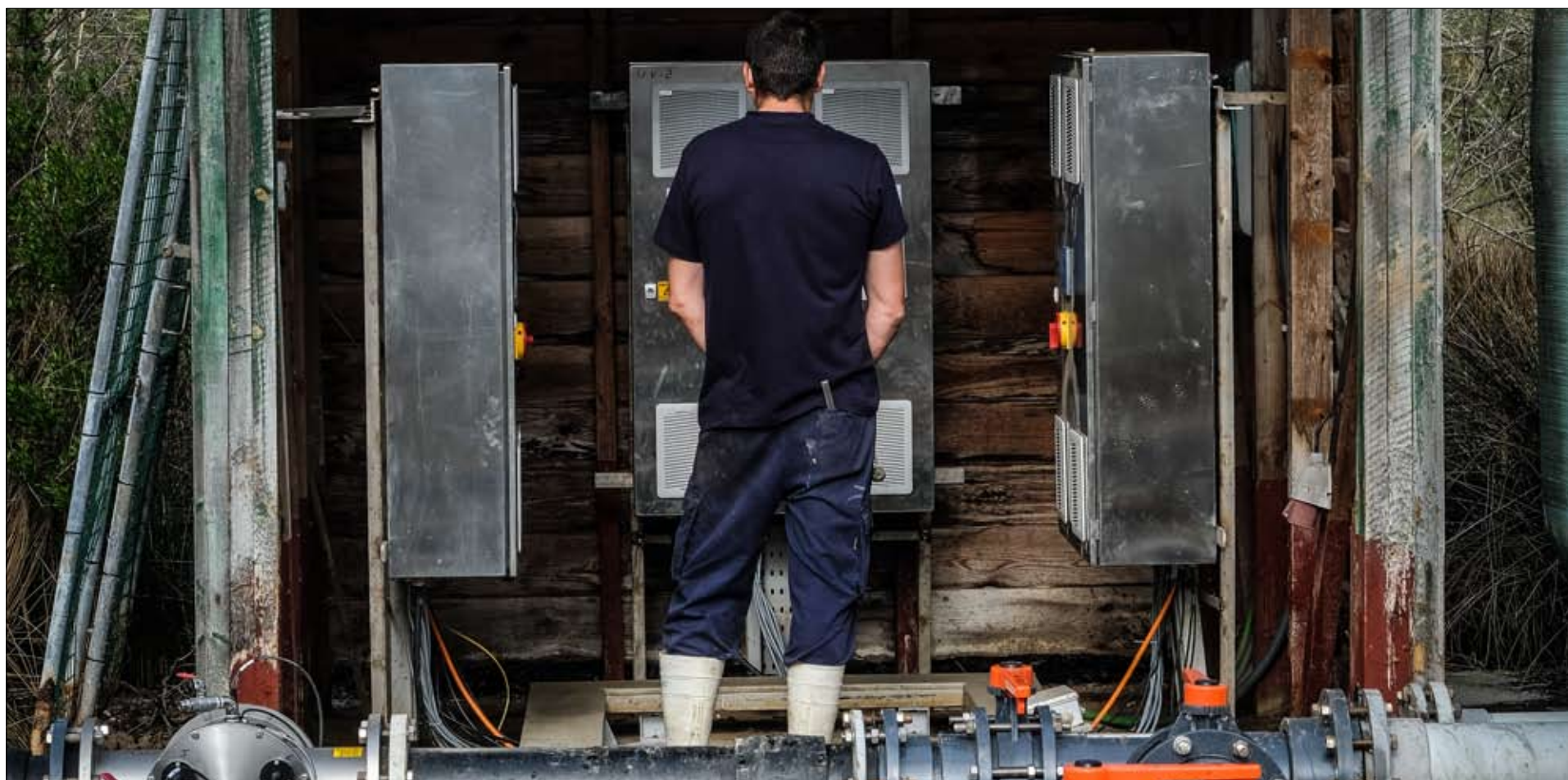
Un operario realizando labores de mantenimiento en una instalación eléctrica. / HARDY
