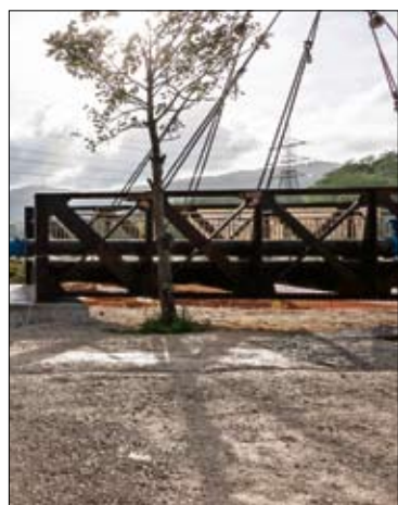
Instalación de la infraestructura.
