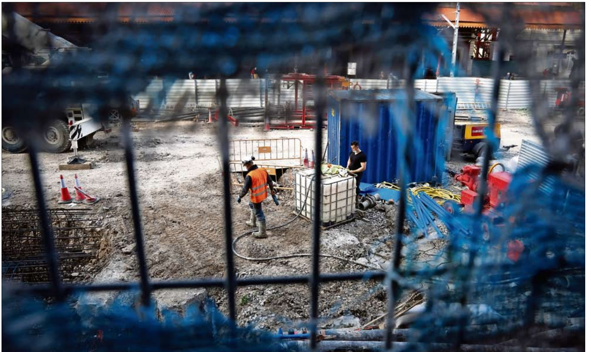
Dos hombres trabajando en una obra de construcción. / JAVIER ETXEZARRETA
