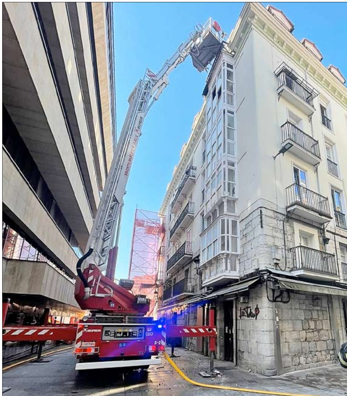
El fuego se desató en el último piso del edificio sin que se conozcan las causas. / ALERTA
