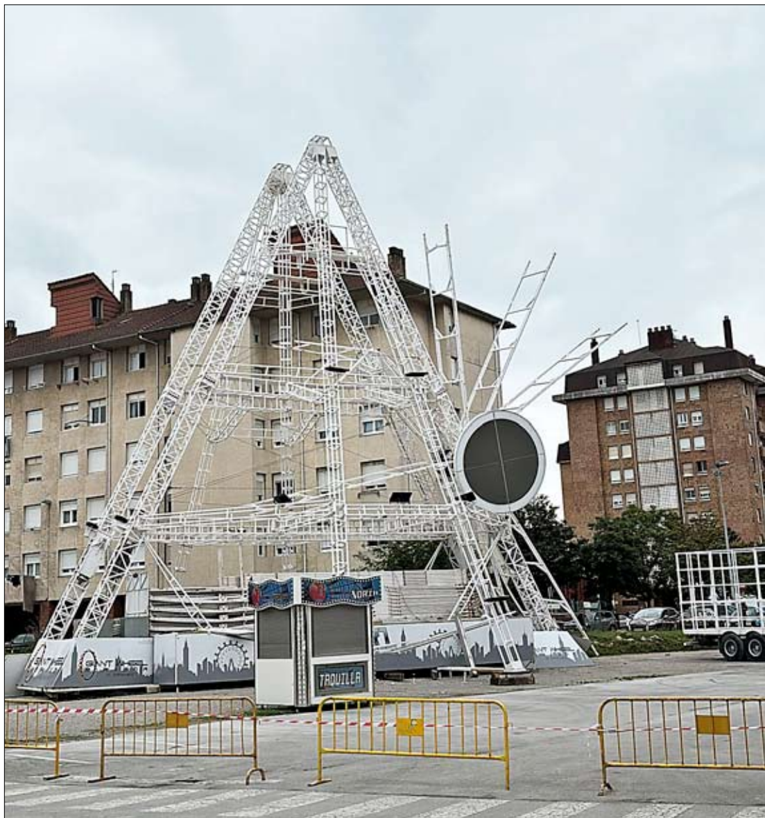
La noria después de caer al suelo durante su desmontaje. / ALERTA
