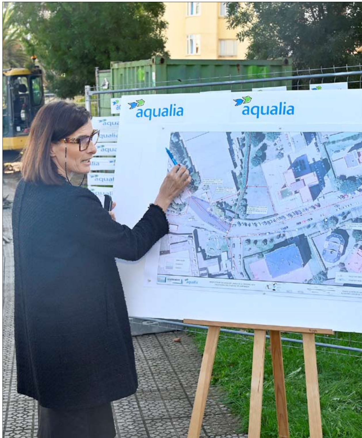
La alcaldesa de Santander, Gema Igual, durante el arranque de las obras de mejora del alcantarillado en la Avenida del Stadium
