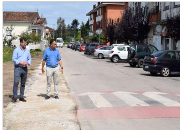
El alcalde de Piélagos supervisando las obras. / ALERTA
